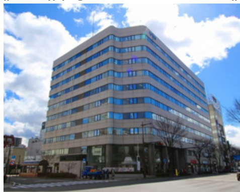
《01 福島セントランドビル》
